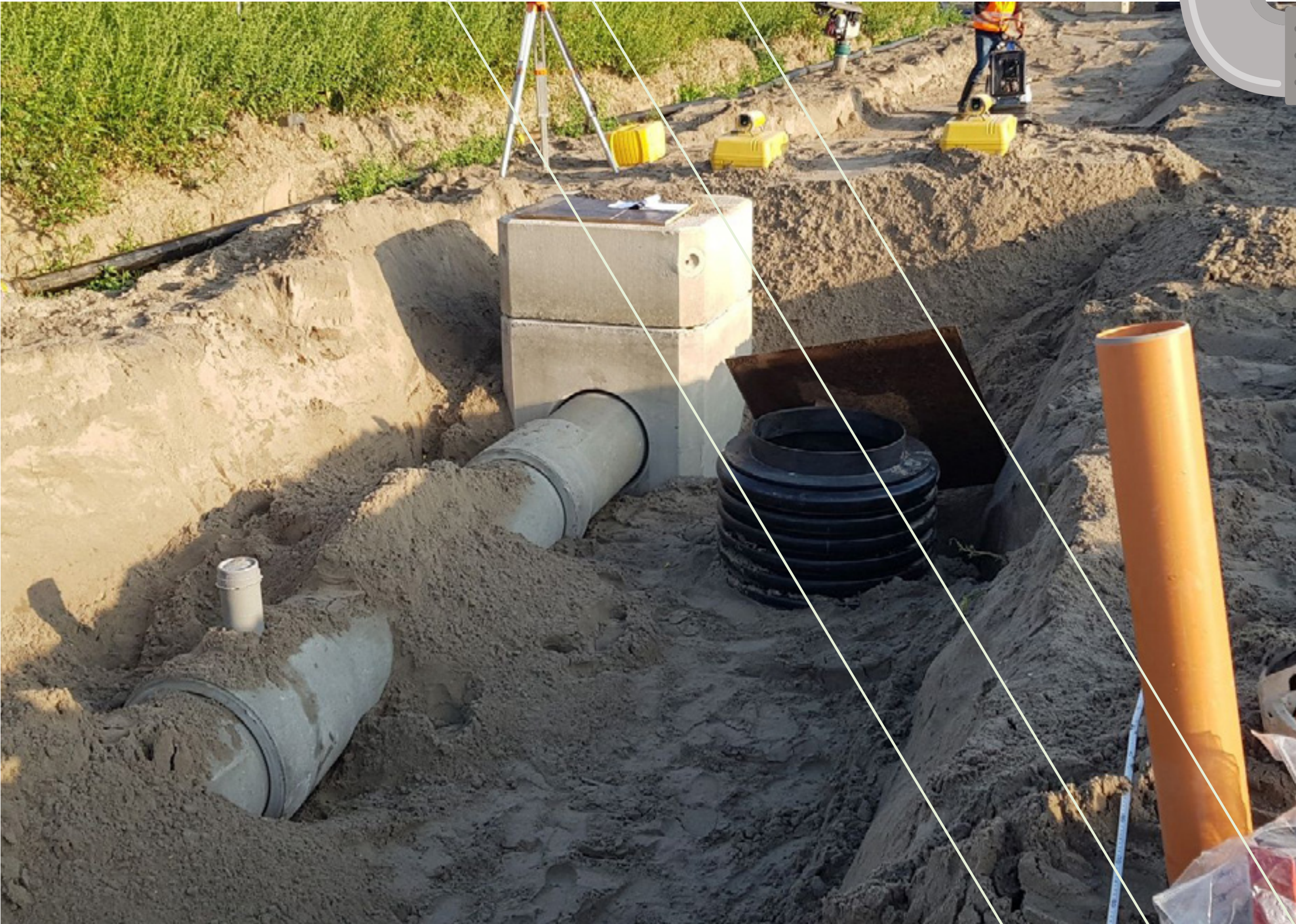
Aanleg van gescheiden riolering
