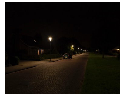
Foto: Keplerlaan; licht is gelijkmatig over de weg verdeeld zodat er geen zwarte vlekken zijn.
