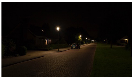
Foto: Keplerlaan; licht is gelijkmatig over de weg verdeeld zodat er geen zwarte vlekken zijn.
