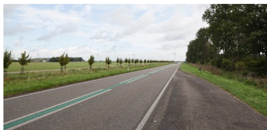
Foto: Belijning die reflecteert waardoor het verloop van de weg goed te zien is.
