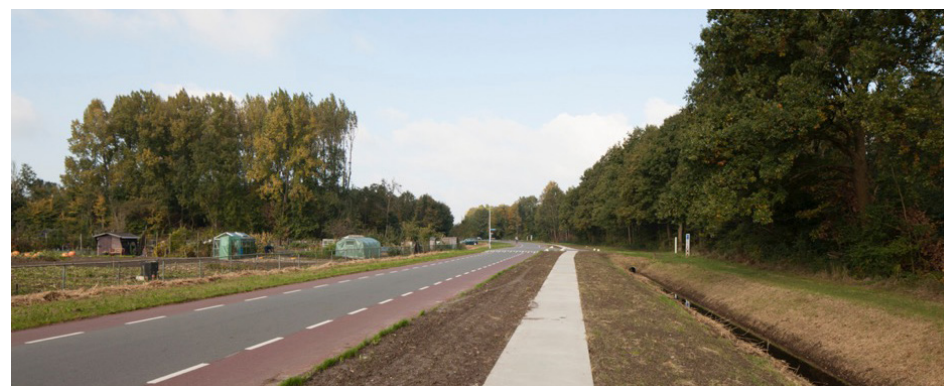
Foto: Bosweg in Swifterbant. Het losliggende pad is van beton en daarmee lichter van kleur (zolang het wegdek droog is). Het fietspad op de weg is roodgekleurd om een goed contrast te krijgen. Je kan dit wegdek ook in het donker laten reflecteren door een toeslagmateriaal erdoor te doen.
