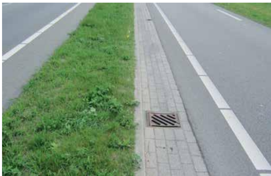
Molgoot in betonstraatsteen
