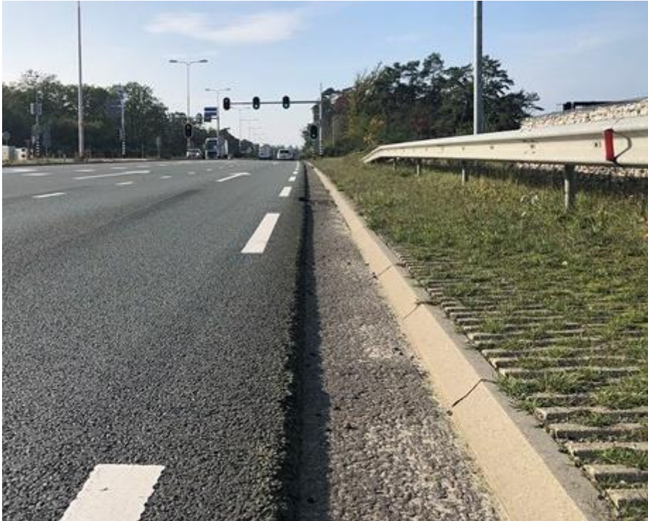
5cm hoge overrijdbare band met grasbetonstrook
